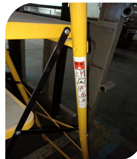
於手扶梯明顯處張貼安全警告圖示
